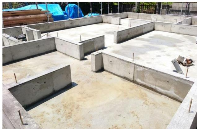
ベタ基礎工法により地盤と基礎が一体化し、布基礎に比べ安定感に優れています。建物自重・積載荷重を分散し、均一に受ける構造なので、地盤への負荷を軽減します。
